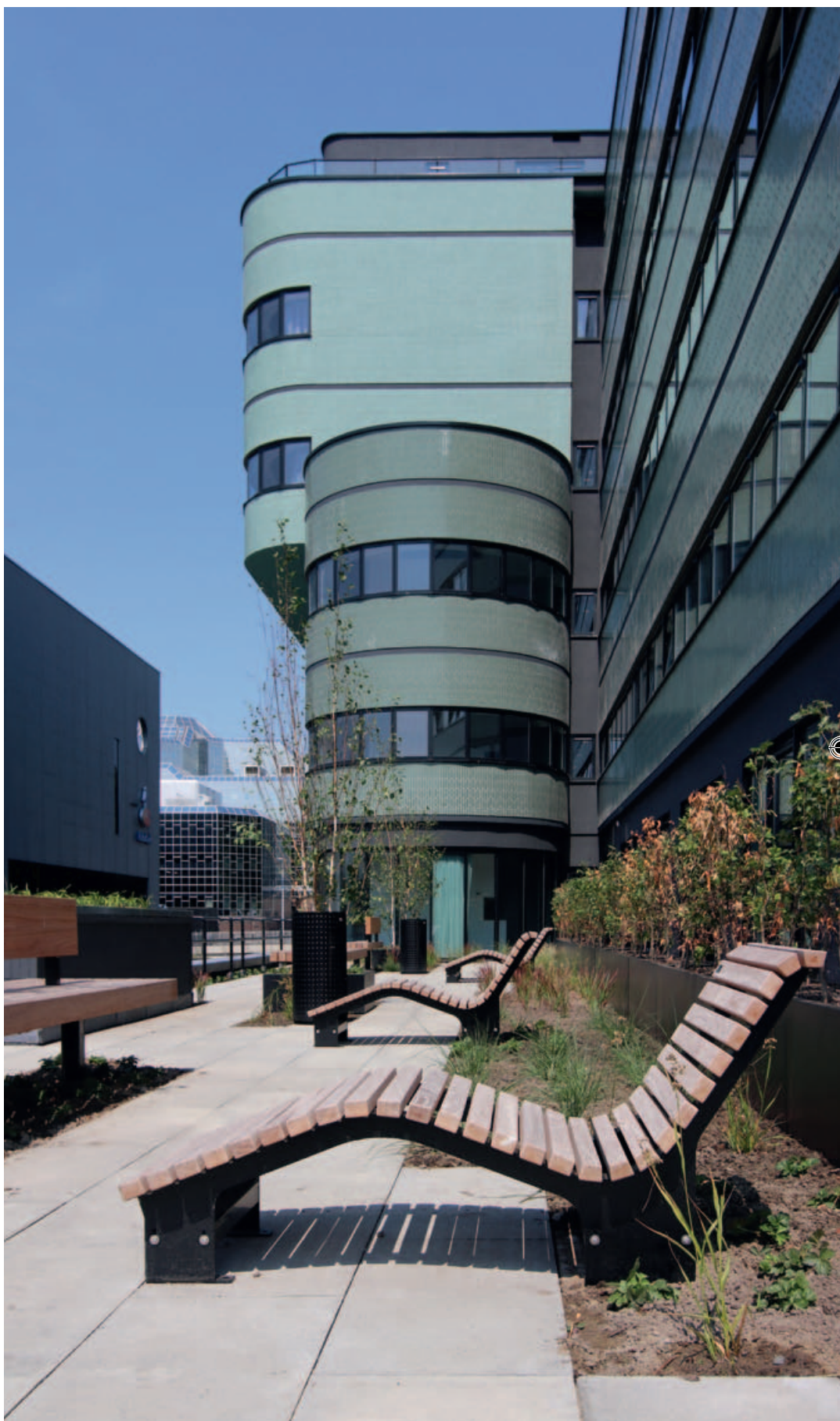
De nieuwe gevels zijn uitgevoerd in drie kleuren geglazuurde steenstrips, die speciaal voor dit project zijn gebakken.
